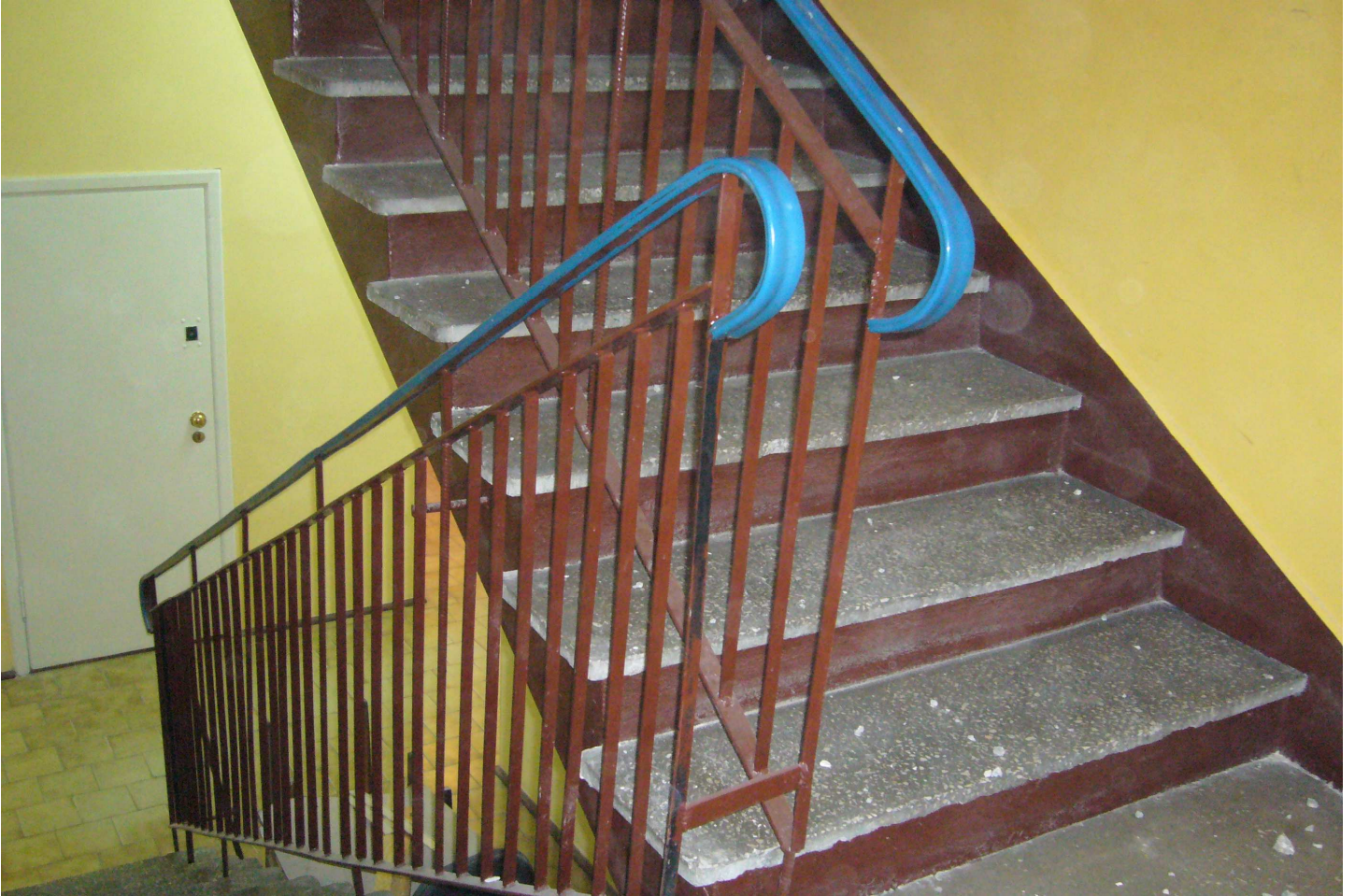
Stan przed realizacją
